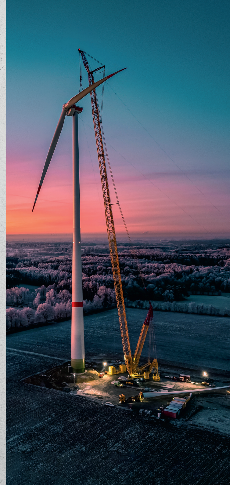
Liebherr-Raupenkran LR 1800-1.0 bei der Errichtung einer Windkraftanlage 2024
